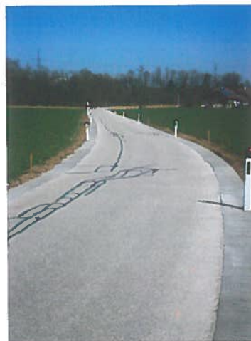
Am Bild sieht man die beschriebene Maßnahme mit der Abgrenzung
