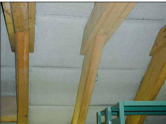
Foto 5: Dach mit Faserzementplatten innen isoliert (SUVAPRO 2007).
