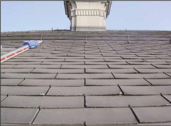
Foto 3: Dach mit Asbestzementschindeln (Eternit) gedeckt (SUVAPRO 2007).
