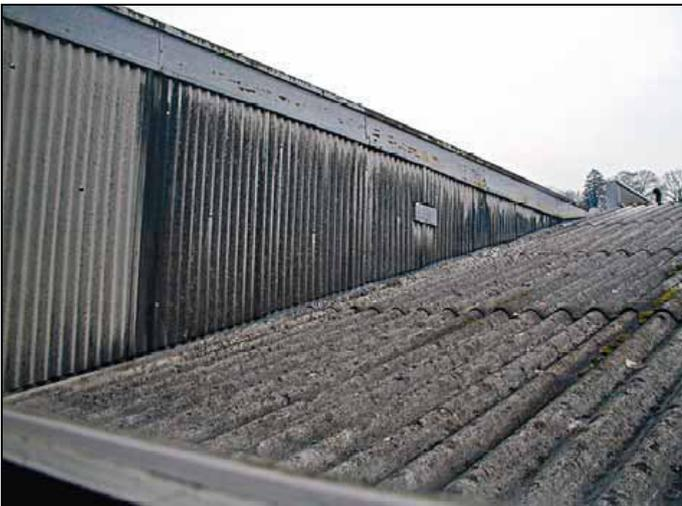
Foto 4: Welldach mit asbesthaltigen Faserzementplatten (SUVAPRO 2007).
