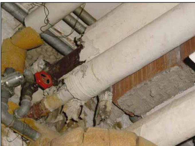
Foto 9: Asbestisolierung um Heizleitungen (SUVAPRO 2007).
