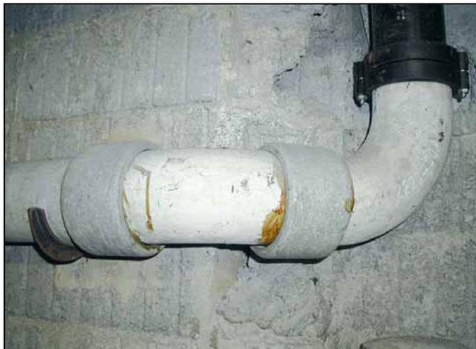
*Foto 7: Abflussrohr aus Asbest (SUVAPRO 2007).*
