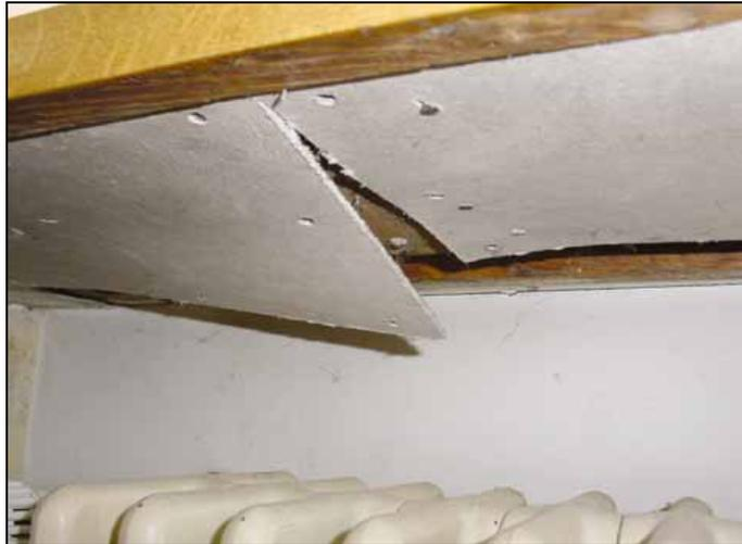
*Foto 6: Asbestleichtpressplatten zur thermischen Isolation einer Fensterbank (SUVAPRO 2007).*
