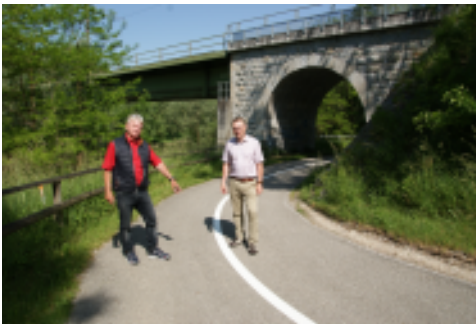
Mehr Sicherheit am Radweg - Bodenmarkierung beim Eisenbahnviadukt, v.l.n.r. Helmut Wolfsgruber u. Max Tiefenthaler
