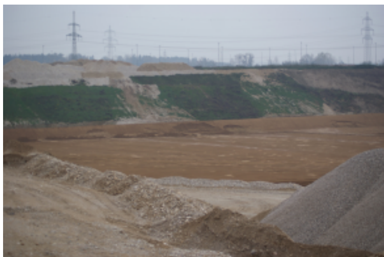
Am Bild die aktuelle Situation in der Baurestmassendeponie
